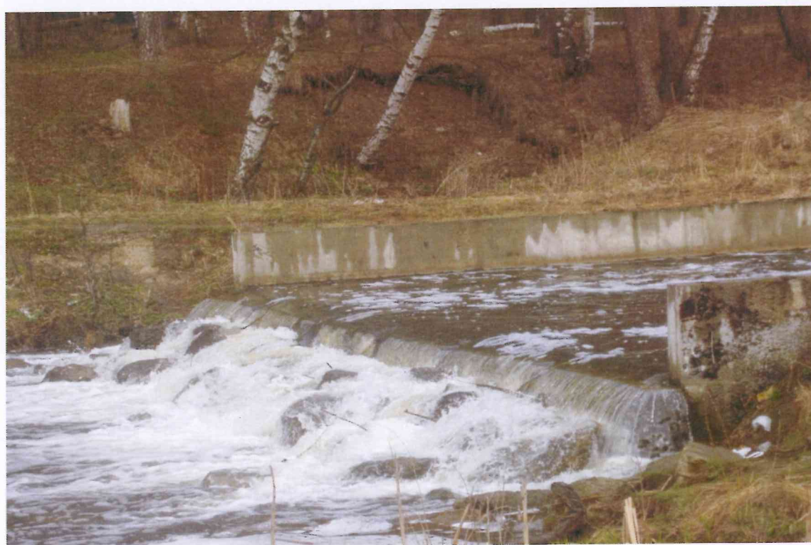
Рис 9. Вид воротки размыва консольной части водосбросного лотка быстроготока
