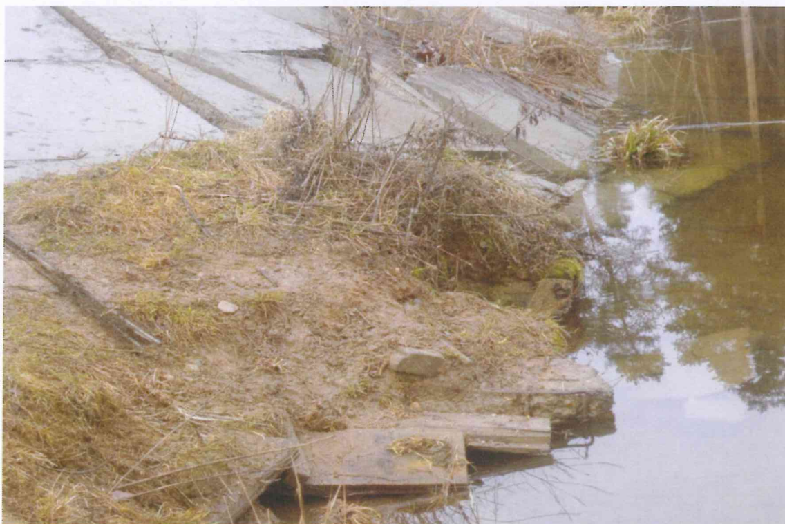
Рис. 3. Железобетонное крепление верхового откоса. Просадки, сдвиги и нарушения деформационных швов.
