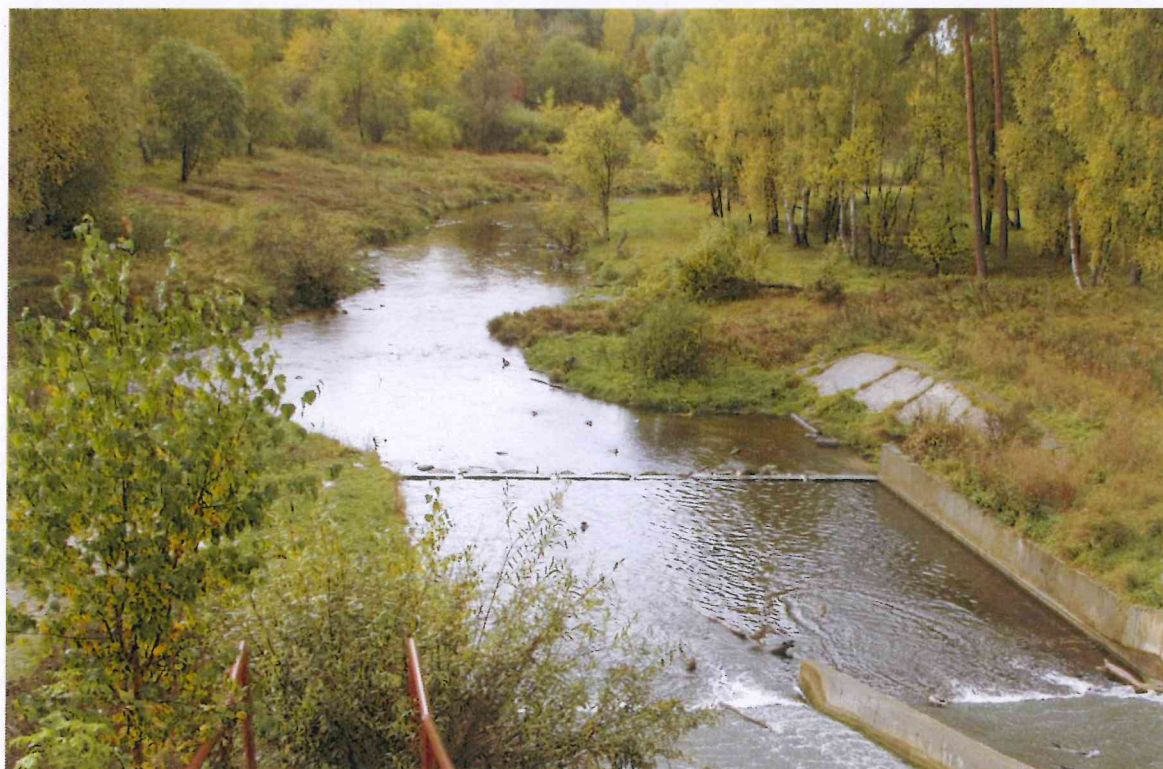
Рис. 5. Размывы отводящего канала водосброса. Нарушенное крепление откосов.
