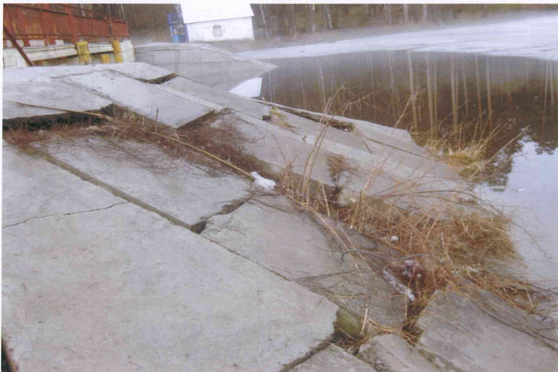
Рис. 2. Верхний бьеф. Разрушенное железобетонное крепление на сопряжении тела плотины с береговыми устоями
