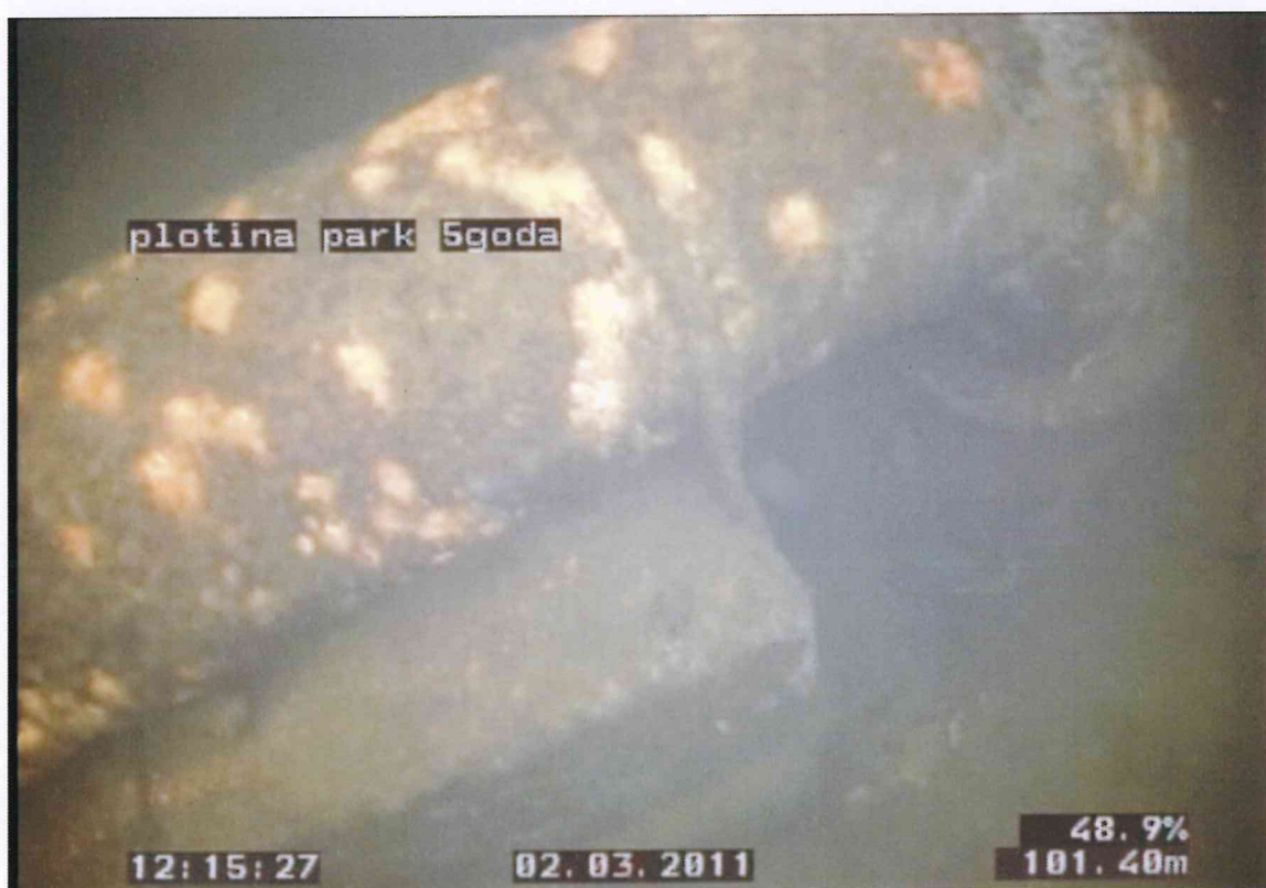
Рис. 7. Сифонный водоспуск. Входной оголовок.
