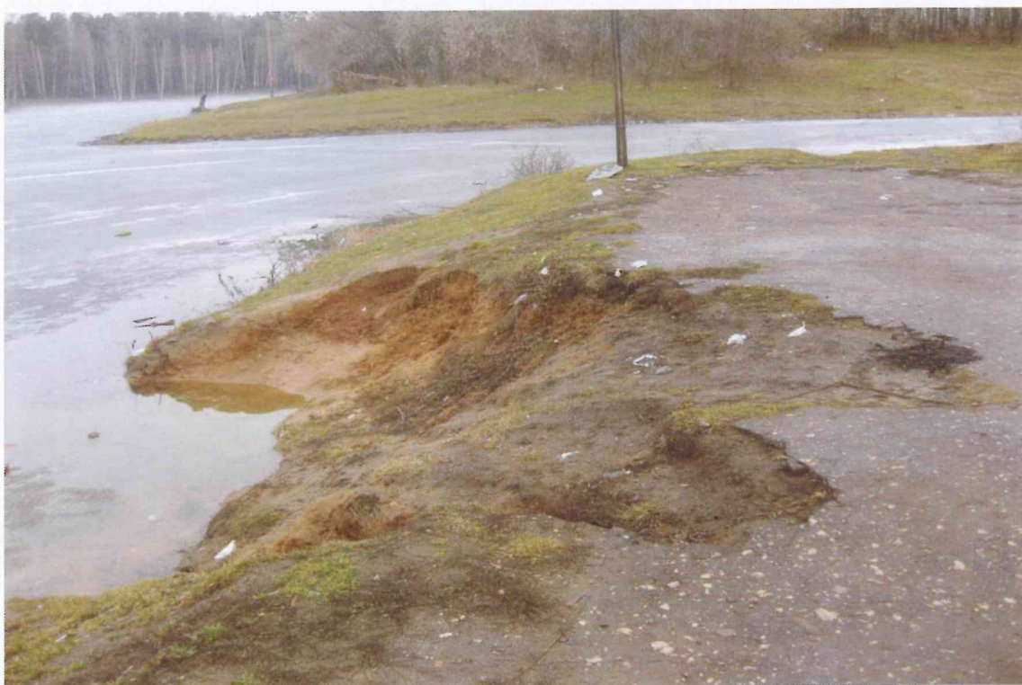
Рис. 6. Промоины откосов плотины на левобережном примыкании)
