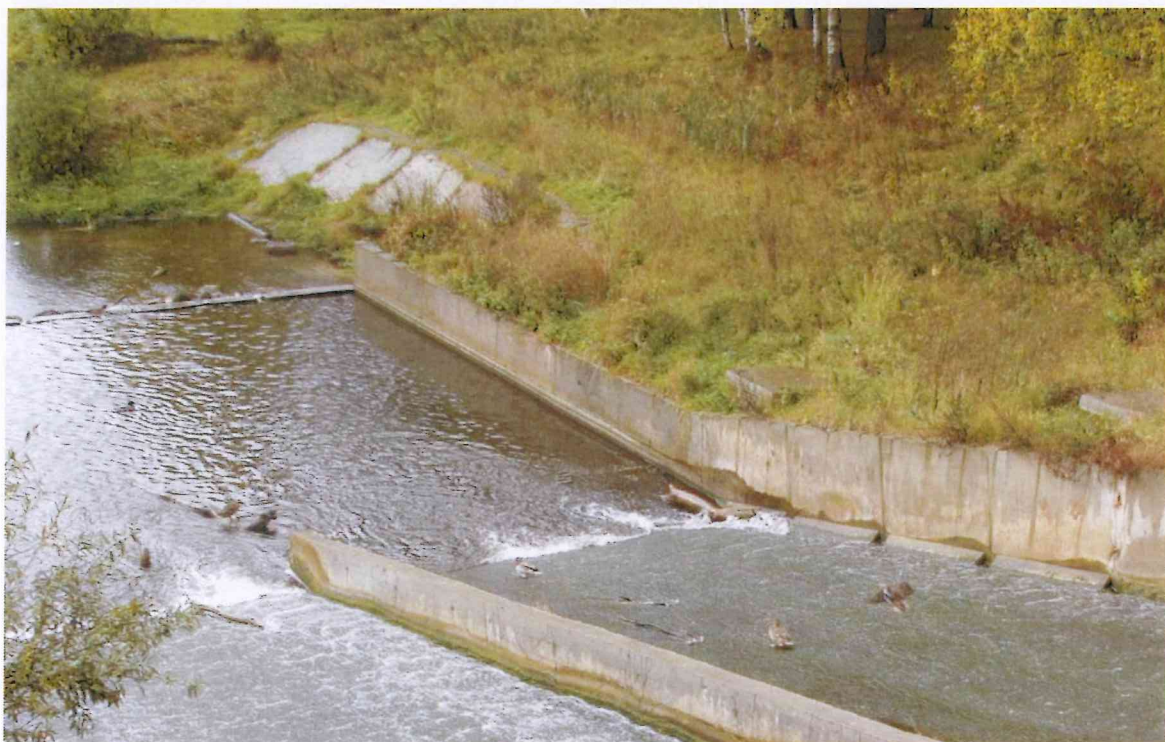
Рис. 4. Нижний бьеф. Просадка грунта в пазухах железобетонного лотка быстрого тока
