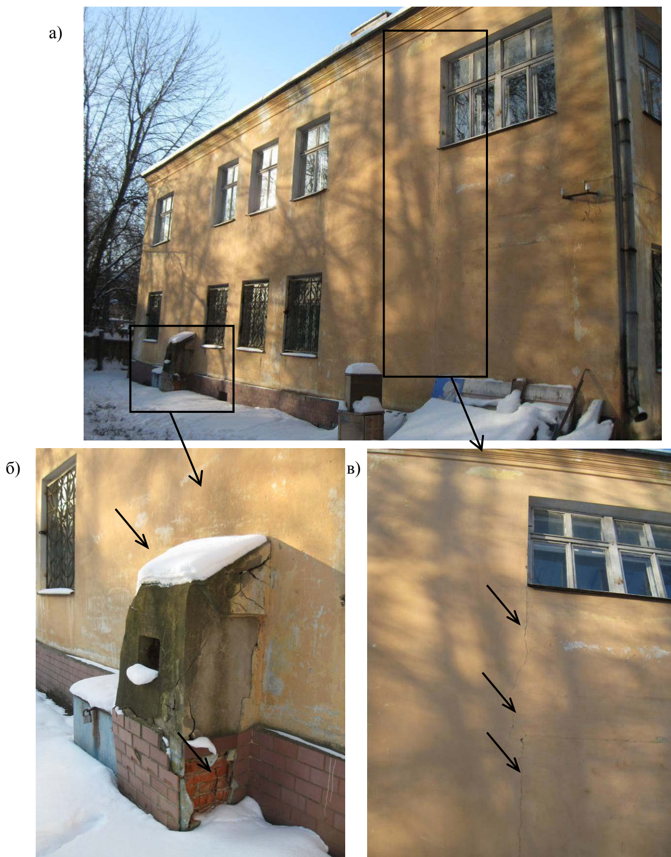
Рис. 2.2. Освидетельствование стен здания по оси 1: а) общий вид стены по оси 1; б) отслоение штукатурки и разрушение кладки вентиляционной шахты; в) и вертикальные трещины в стене в месте заложения проема первого этажа (бывшей веранды). Аналогичное повреждение выявлено и по оси 6 – В
