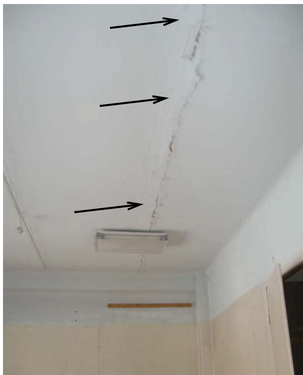
Рис. 3.2. Освидетельствование плит перекрытия над вторым этажом: а) в осях 1 – 2 по ряду Б; б) по оси 2 пролета Г – Д. выявлены трещины в швах между плитами и участки выпадения раствора заделки рустов. Участки увлажнения конструкций перекрытия
