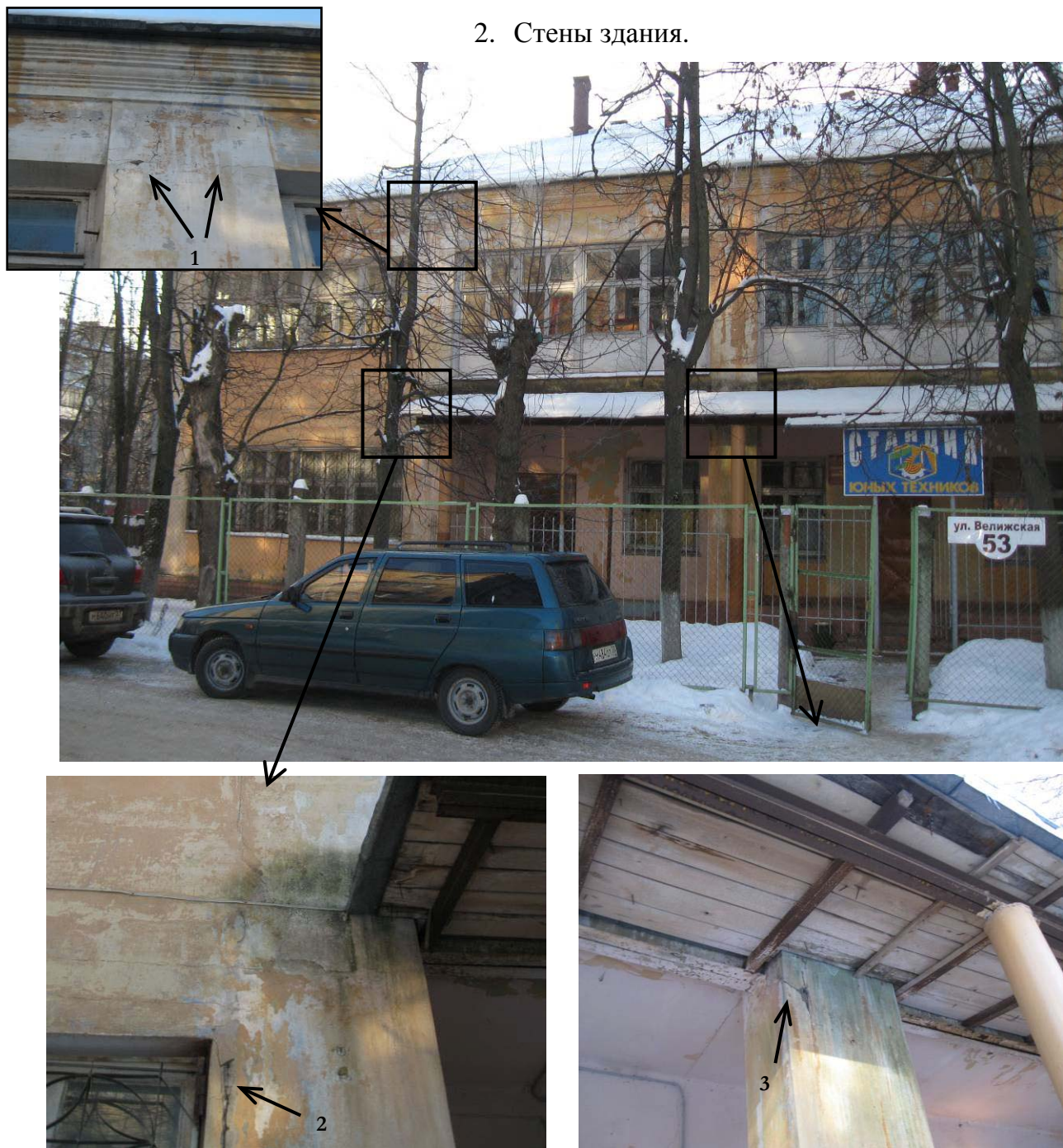
Рис. 2.1. Освидетельствование стен здания по ряду А: 1 – трещины по грани перемычек над оконными проемами; 2 – трещина по грани оконного проема, свидетельствующая об отслоение штукатурки откоса; 3 – трещина по боковой грани кирпичного столба по оси 3/1 – А ; 4 – увлажнение кладки над козырьком
