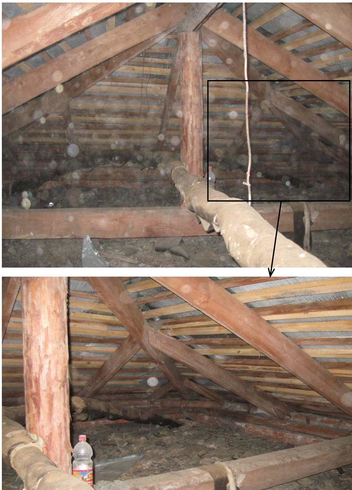
Рис. 4.2. Освидетельствование стропильных конструкций кровли: комбинированная система строил в осях Д – Е: стропильные ноги из бруса 50х180 мм уст ановлены также с шагом 1200 мм, затяжка выполнена из бруса 140х200 мм, стойка и коньковый брус – из бревна Ø150 мм. Участков гниения древесины не выявлено
