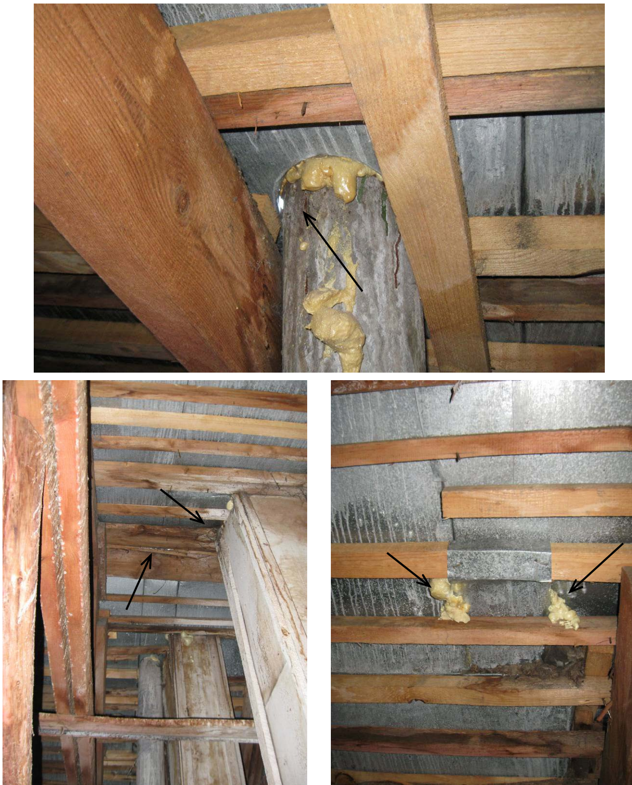
Рис. 5.1. По свидетельству обслуживающего персонала ремонт кровли выполнялся в 2008 г. При обследовании выявлены отдельные участки нарушения герметичности стыков листов кровли и зазоры в местах прохода вентиляционных шахт через кролю. Зазоры заполнены «монтажной пеной». Сплошная обрешетка в ендове отсутствует. Элементы системы безопасности (снегозадержание, ограждение) на кровле отсутствуют
