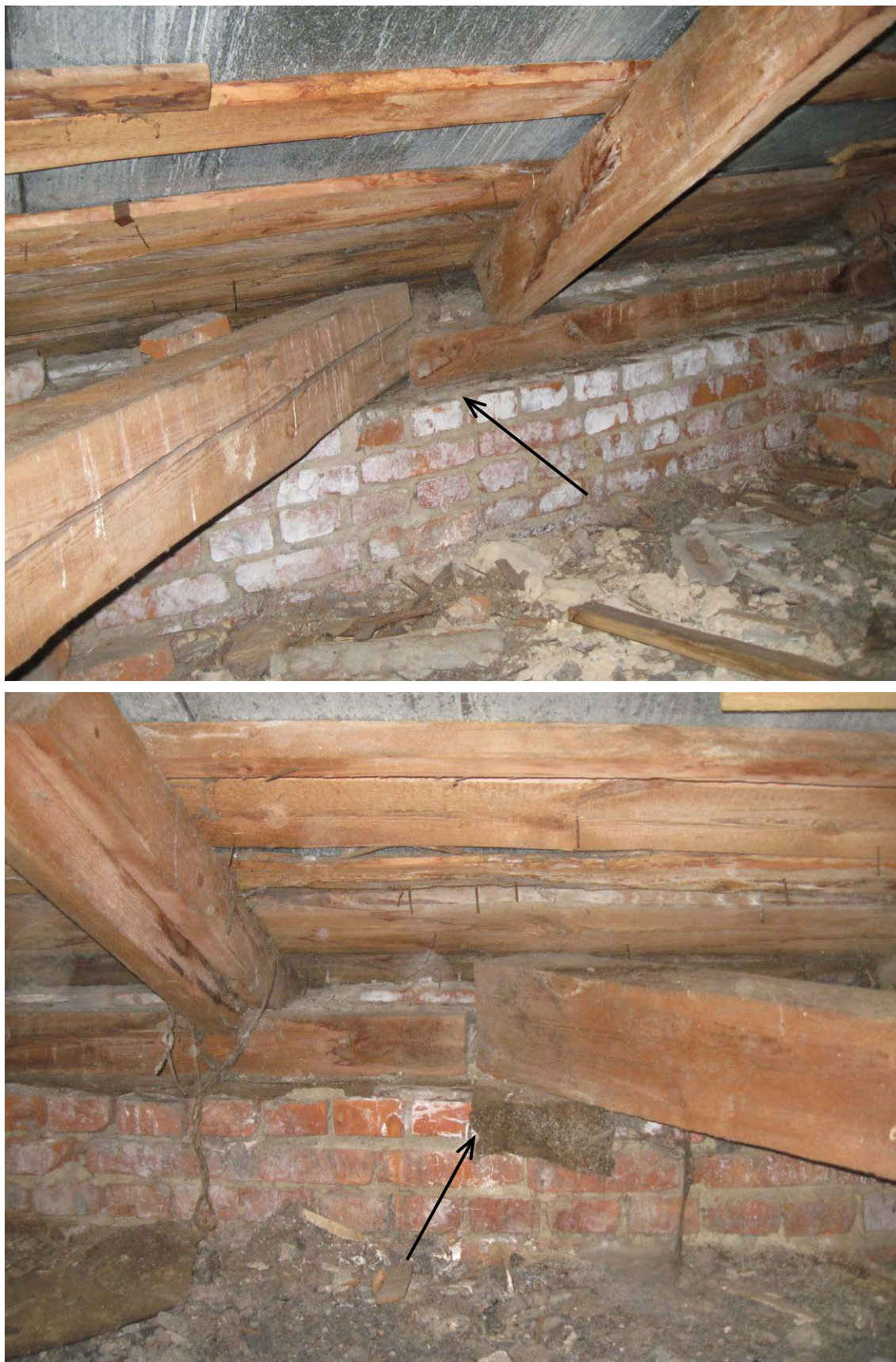
Рис. 4.3. Мауэрлат по ряду А разрезан по длине диагональными (угловыми) брусьями. В местах контакта дерева с кирпичной кладкой имеется рулонная гидроизоляция
