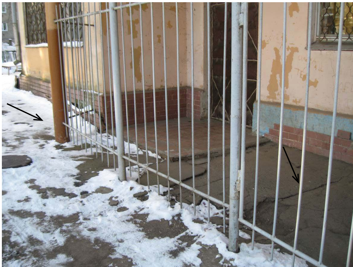
Рис. 6.1. Повреждения отмостки: наличие контруклонов и трещин в отмостке
