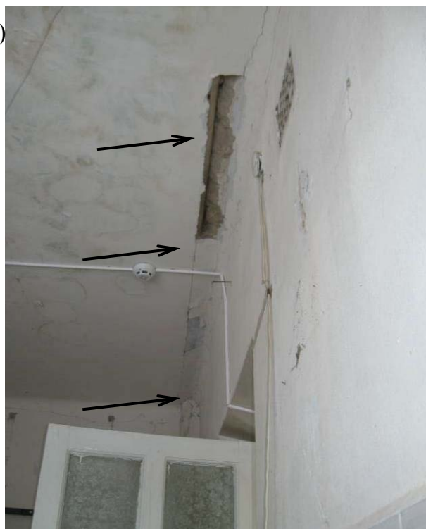
Рис. 3.2. Освидетельствование плит перекрытия над вторым этажом: а) в осях 1 – 2 по ряду Б; б) по оси 2 пролета Г – Д. выявлены трещины в швах между плитами и участки выпадения раствора заделки рустов. Участки увлажнения конструкций перекрытия
