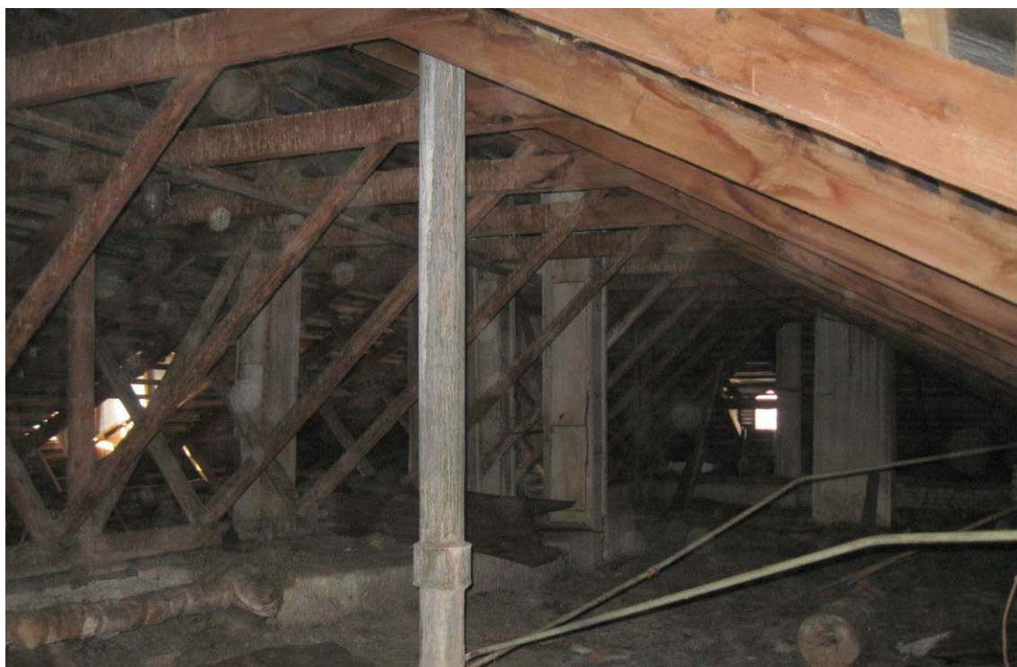
Рис. 4.1. Освидетельствование стропильных конструкций кровли: наслонная система стропил в осях А...Д: стропильные ноги из бруса 50х180 мм установлены с шагом 1200 мм
