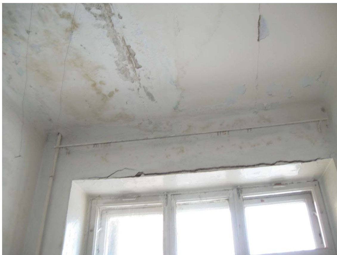
Рис. 2.6. Освидетельствование внутренней поверхности стен по оси 2 – Д: увлажнение стен в результате протечек с кровли и повреждения системы наружного организованного водостока
