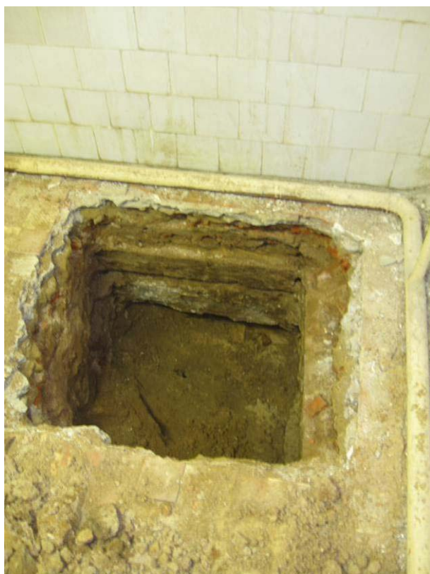
Рис. 1.1. В результате освидетельствования фундаментов установлено, что под несущие и самонесущие стены выполнены ленточные фундаменты из монолитного железобетона с шириной подошвы: под несущие стены – 1250 мм, под самонесущие – 750 мм
