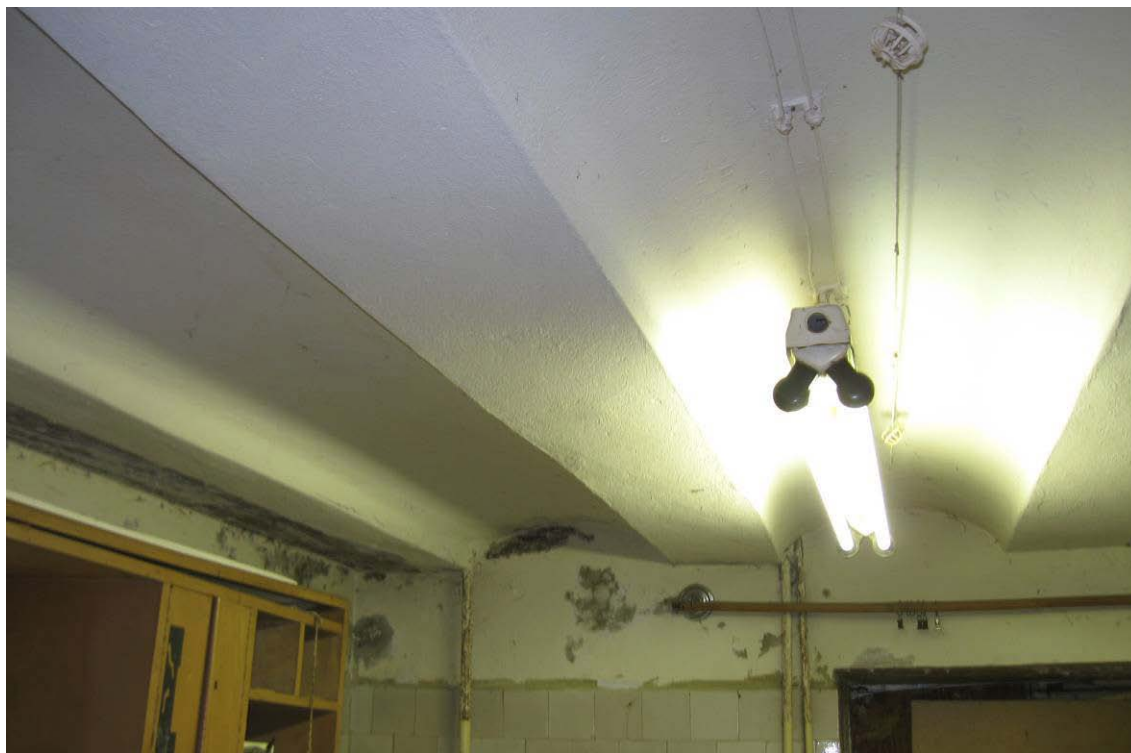
Рис. 3.1. Освидетельствование плит перекрытия над подвалом в осях 1 – 2, В – Г – сборные железобетонные корытообразные плиты с размерами в плане 6,0×1,0 м. Силовых повреждений не выявлено
